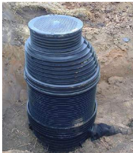
5.10 Pav. Kontroliuojamo įlipamojo drenažo šulinio schema. Kairėje šulinio brėžinys, dešinėje - nuotrauka šulinio montavimo metu. (aut. V.Gasiūnas)
